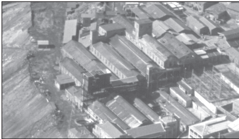
Panoramica dell'impianto di elettrolisi dello zinco, 1990, a Monteponi (Iglesias-Cagliari). Fonte: Aeronike
