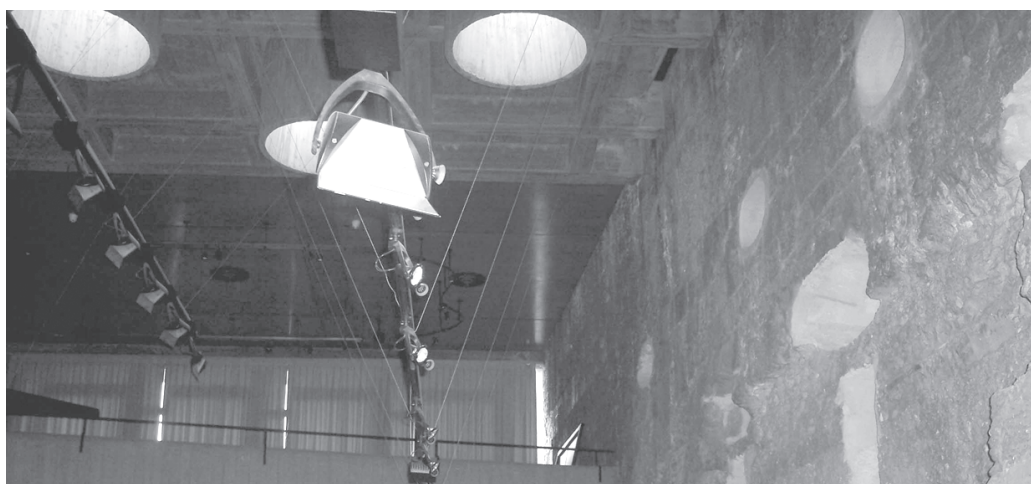
Cagliari. Cittadella dei Musei, dettaglio costruttivo degli interni che mostra il legame tra le vecchie e le nuove strutture
