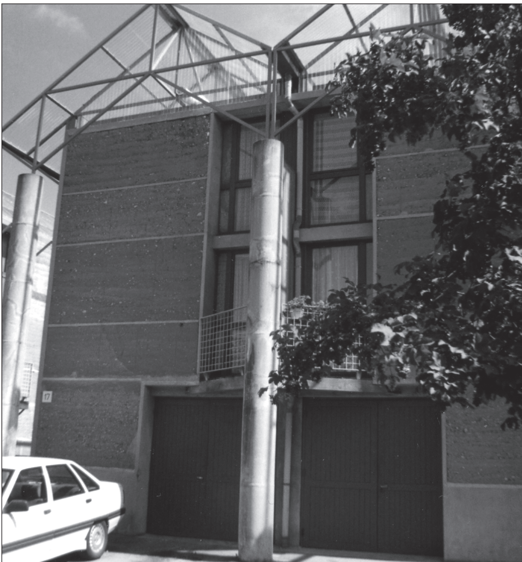
Vista dell'edificio sperimentale in pisè, con copertura trasparente, realizzato dall'architetto Jourda.
