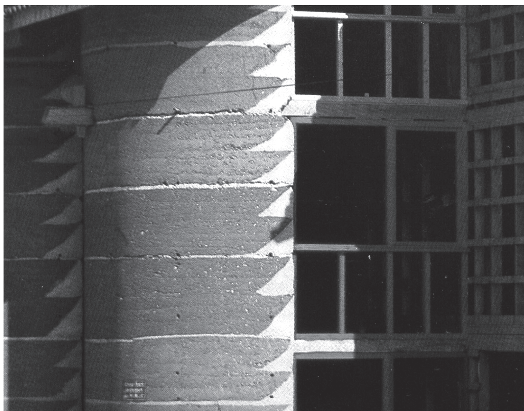
Particolare dei muri curvi in pisè , dei vani scala, dell'edificio dell'architetto Perraudin, n° 6 della planimetria.
