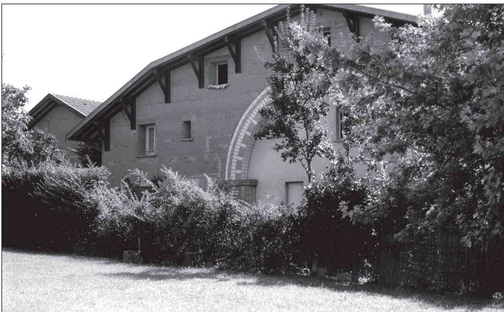
Veduta del fabbricato in pisè, terra non stabilizzata, dell'architetto Odile Perreau Hamburger a 18 anni dalla realizzazione.
