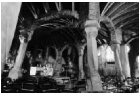
Cripta Colònia Güell (1908-1914). A. Gaudí: struttura con colonne basaltiche disegnata a partire da un plastico di fili (foto L.G.).
