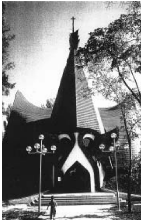
Imre Makovecz, chiesa luterana a Diofok in Ungheria (1986-90). Il Makona Group, fondato da Makovecz, è un gruppo di architetti che si ispira alla tradizione antroposofica e cerca di progettare case che abbiano una memoria e che divengano per gli uomini tramite tra terra e cielo.
