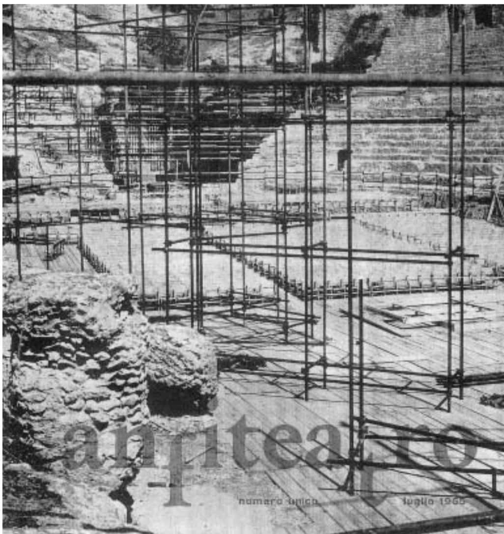
Cagliari, Anfiteatro romano. Sistemazione dei tubi e tavolato di legno (1956-1965).
