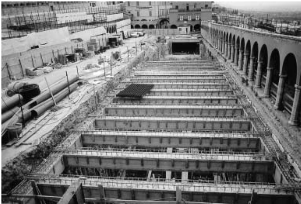
Struttura portante del solaio di calpestio.
