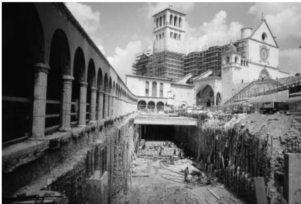
Opere di scavo e consolidamento.
