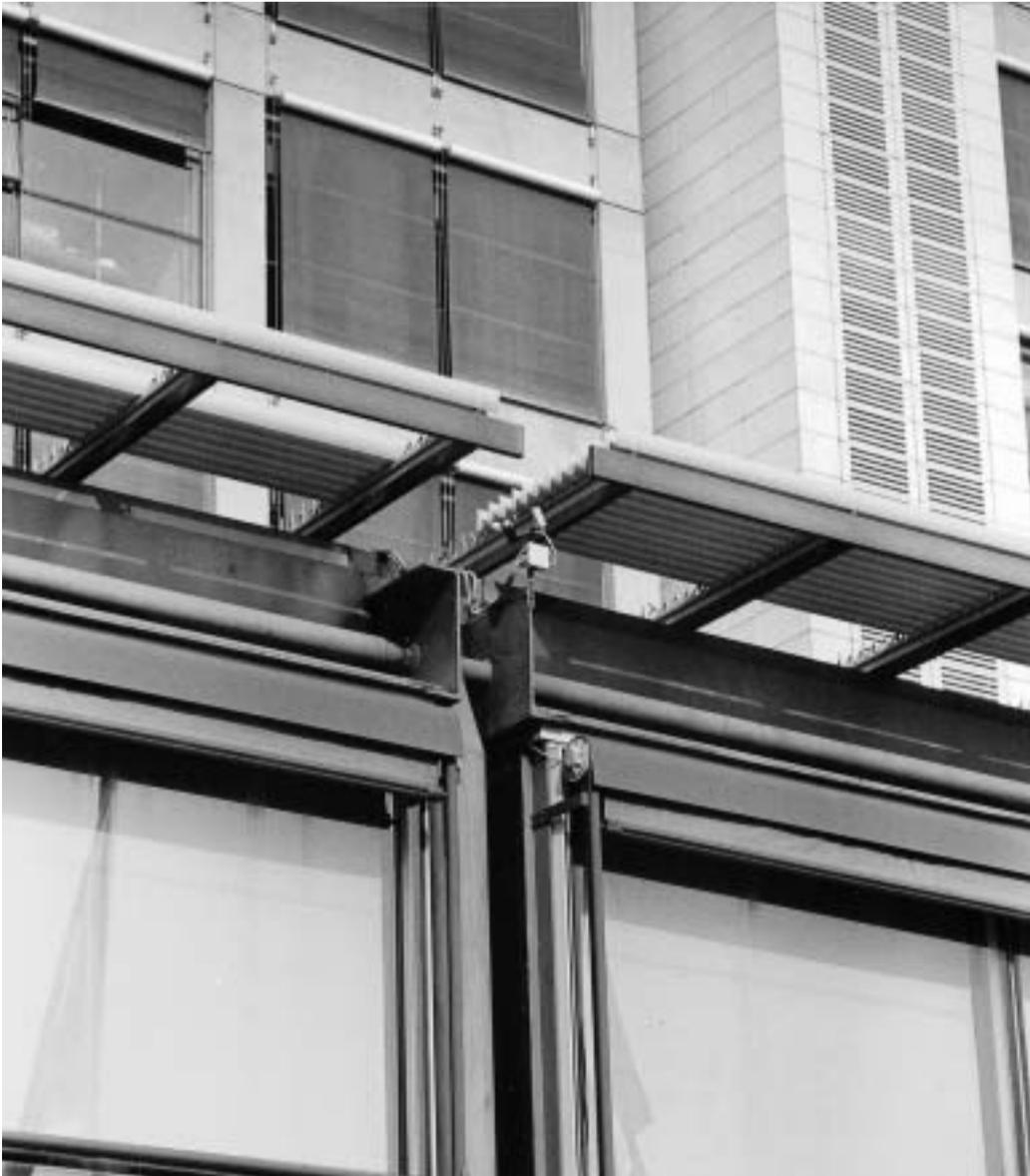
Particolare dei sistemi di controllo climatico dell'edificio: brise-soleil in lamelle orientabili, tende oscuranti esterne antinfiammabili, pannelli-griglie in pietra detta *biancone*.
