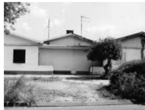
Veduta di dettaglio della loggia fra le tipologie tipo "B".
