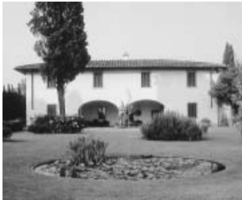
Veduta della casa e della vasca dal fondo del giardino.
