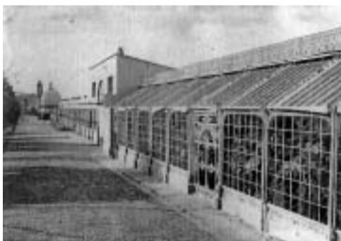
Veduta delle Serre di San Donato. Gran parte delle serre di ferro e vetro che si estendevano per oltre 400 metri, realizzate per ospitare la collezione di piante rare acquistate dal Barone Huegel di Vienna, furono disegnate direttamente da G. Martelli.
