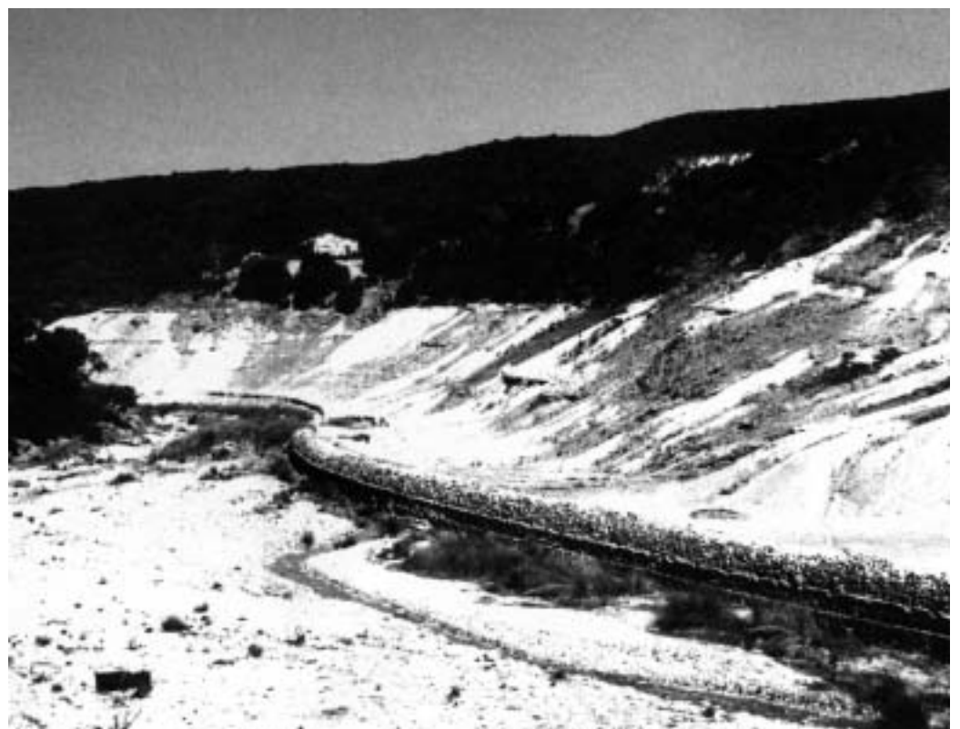
Cagliari, Arbus. Rio Piscinas, canalizzazione idrica nel sito minerario dismesso.
