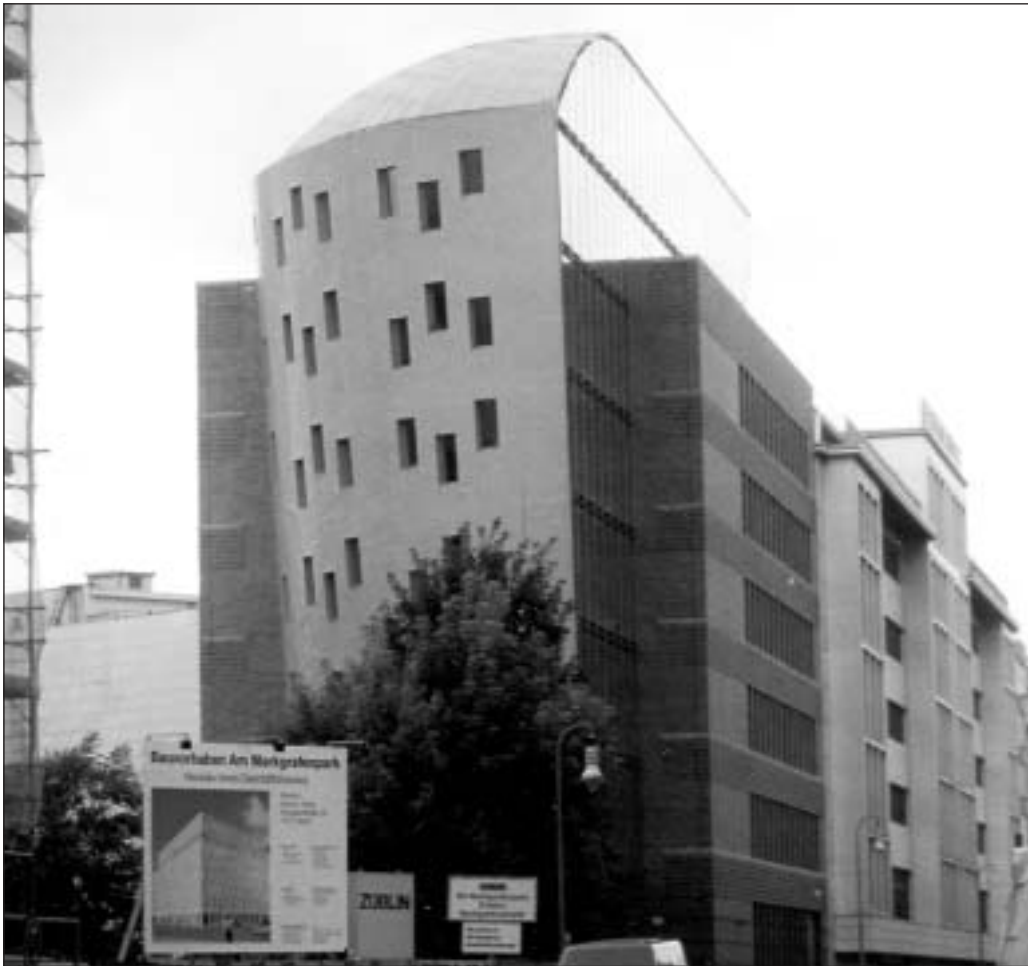
Berlino Est - Edificio per una banca (F. D. Gehry)
