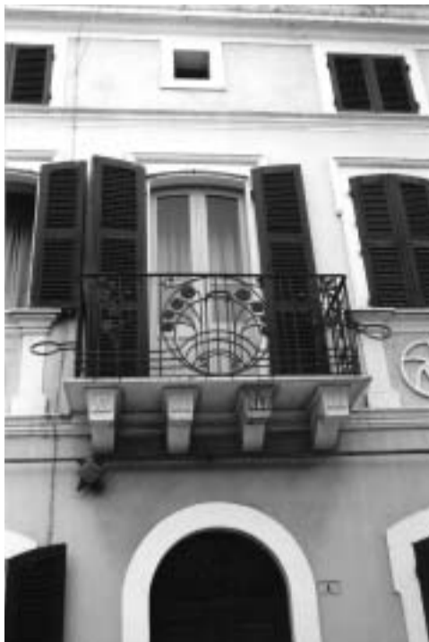
Pozzomaggiore (SS). Inferriata di un balcone in stile Liberty.
