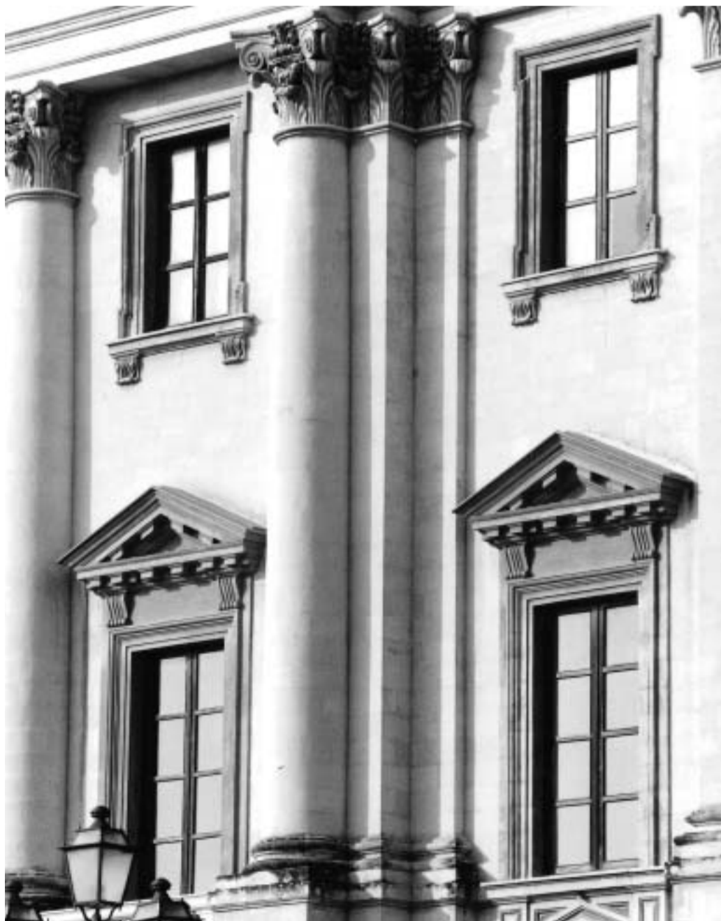
Sassari. Palazzo della Provincia, dettaglio della facciata, 1873-80 (Giovanni Borgnini ed Eugenio Sironi).
