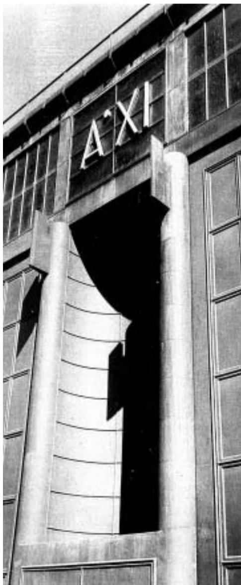
Elmas (CA). Particolare dell'aviorimessa metallica con l'indicazione dell'anno dell'era fascista, oggi rimossa (A. Midana).
