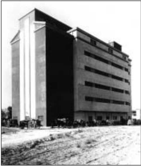
Cagliari. Silo del Consorzio Agrario, 1937 (Alberto Sanjust).
