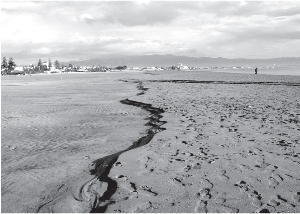
Figura 3 - Irregolarità della superficie di spiaggia legati alla disomogeneità dei materiali di ripascimento e al diverso livello di costipamento indotto dai mezzi meccanici e dall'azione del moto ondoso
