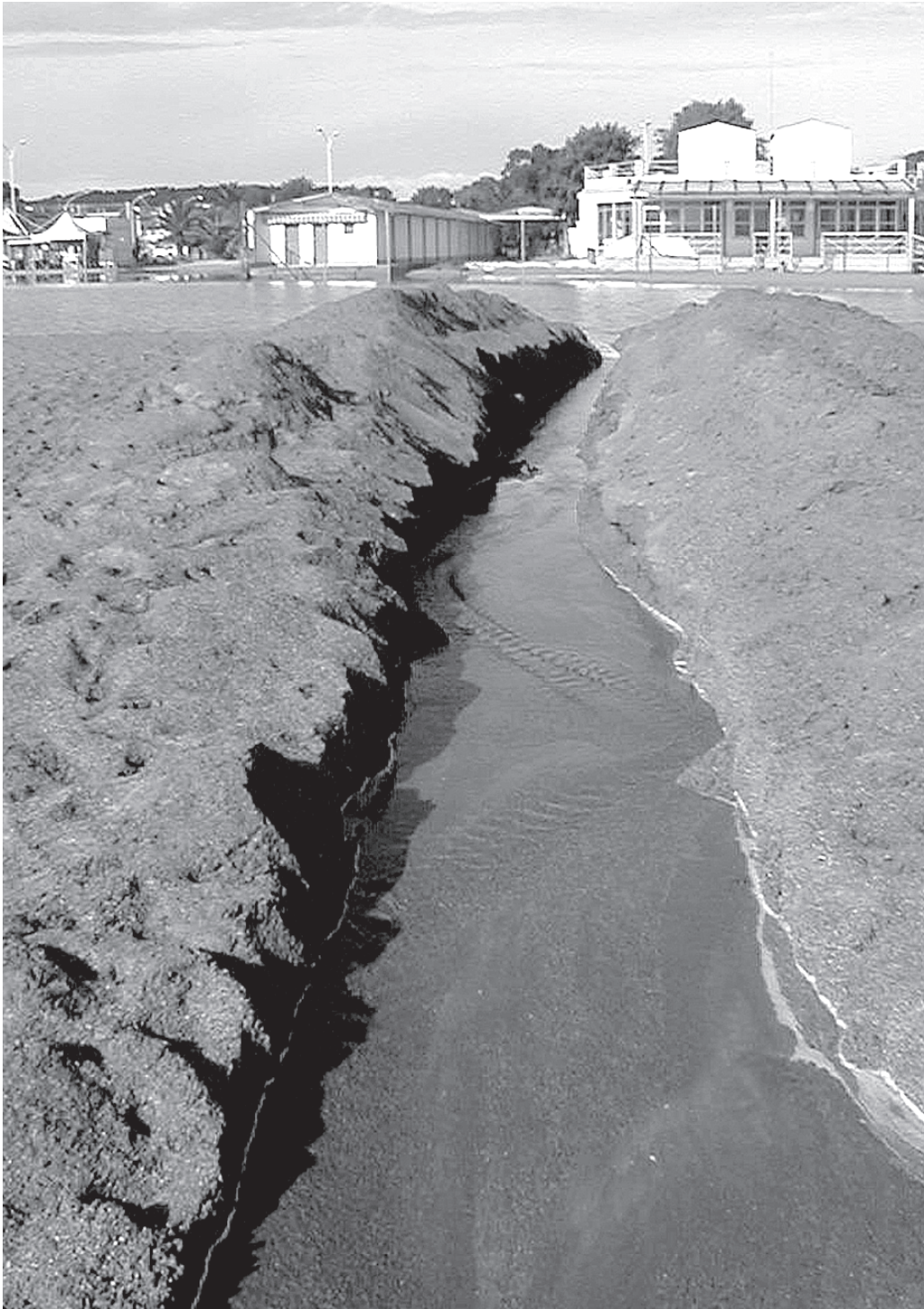
Figura 7 - Uno dei tanti interventi 'creativi' per correggere i danni del ripascimento
