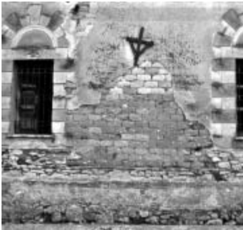
Is Domus (particolare architettonico)
