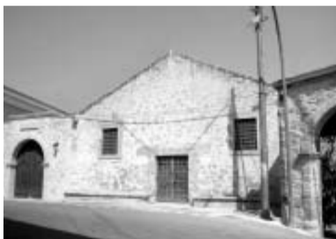
Monte Granatico di Collinas, Cagliari: fronte
