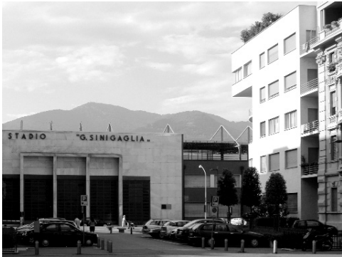
Como. Novocomune e stadio
