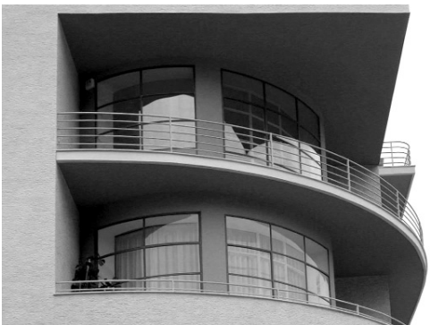
Como. Novocomune, facciata. Dettaglio d'angolo.
