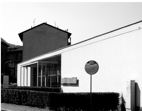
Como. Asilo S. Elia, Fronte principale.
