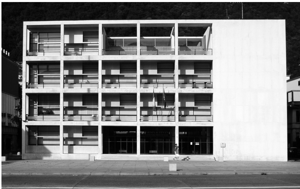
Como. Casa del Fascio. Fronte principale
