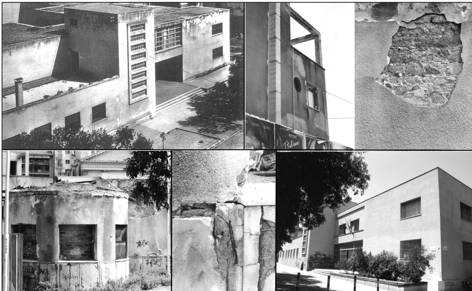
11. Immagini dello stato di degradazione e fatiscenza dell'edificio nei suoi aspetti tipologici, nei particolari materiali e nelle sue componenti tecnologiche.
