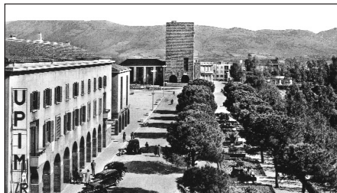
Carbonia, veduta della Torre Littoria
