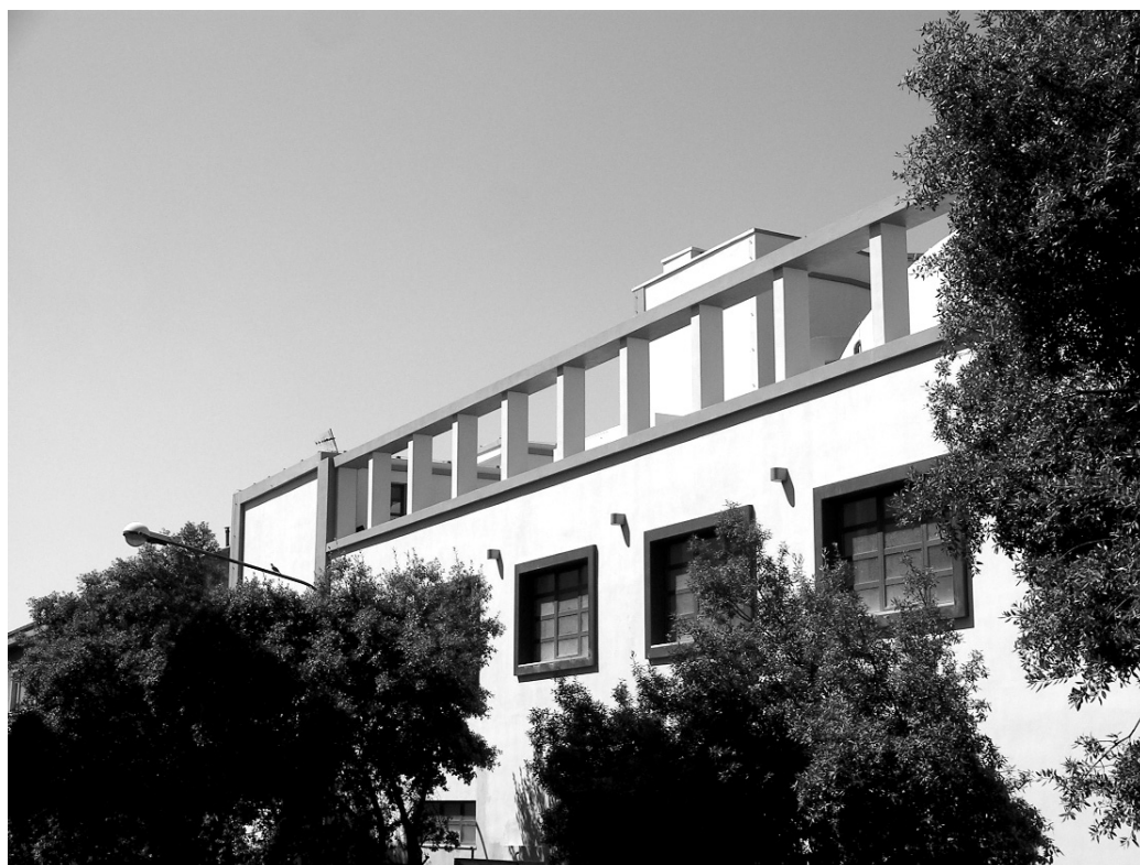
Cinema Teatro Eliseo di Nuoro (particolare del prospetto dopo il restauro)
