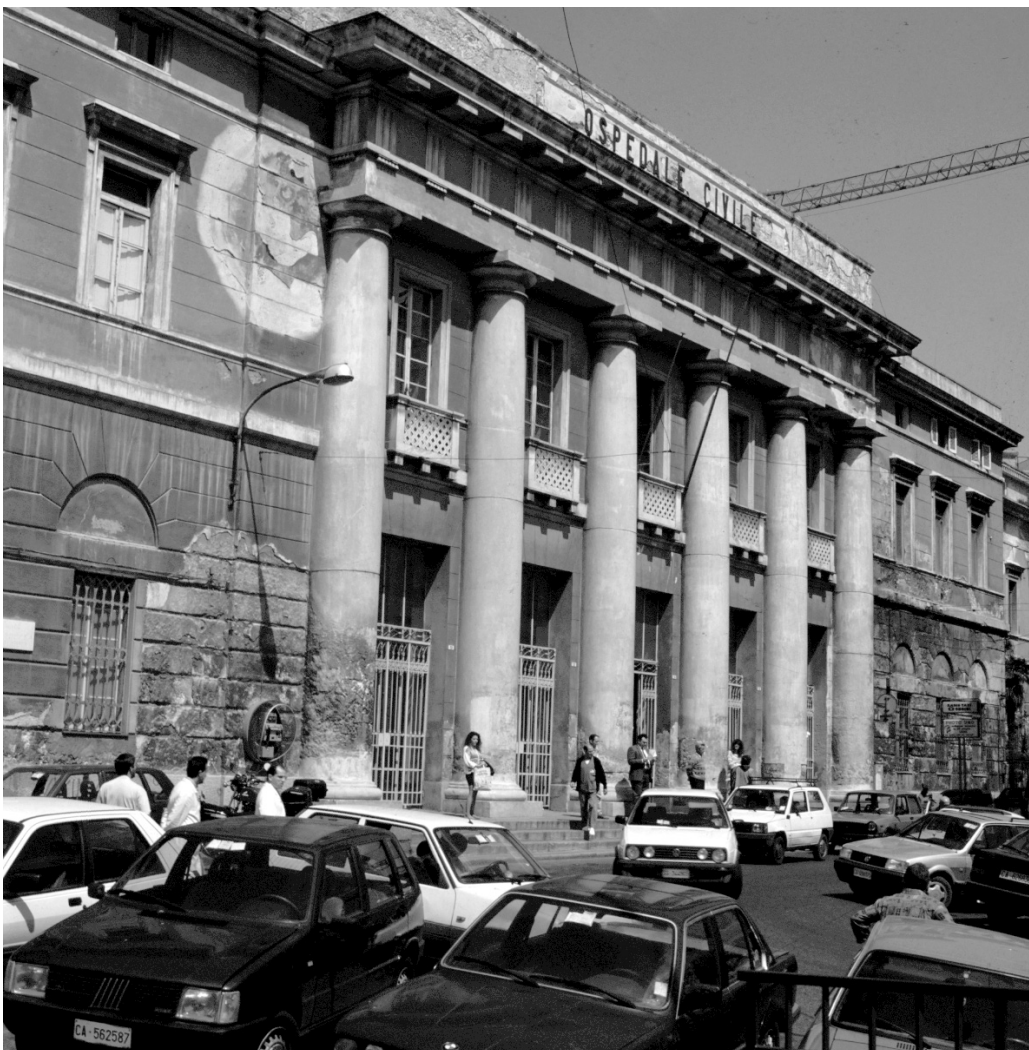
Cagliari. Ospedale Civile (1844-1878). Veduta dell'ingresso.
