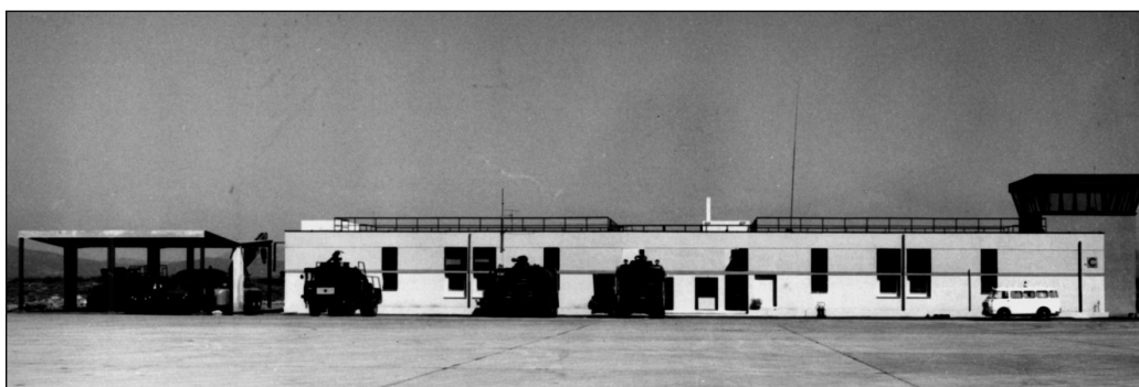
Francesco Cellini, l'edificio della caserma dei Vigili del Fuoco presso l'aeroporto di Olbia, appena realizzato.
